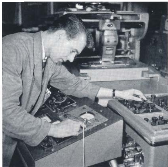
Messungen am Farbverstärker
