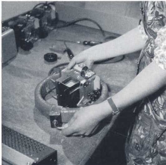
Abgleich der Graviersystemempfindlichkeit mit der Entmagnetisierungsspule
